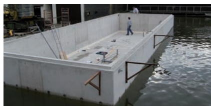
Kijkpunt 8: Een betonnen bak kan ook drijven
