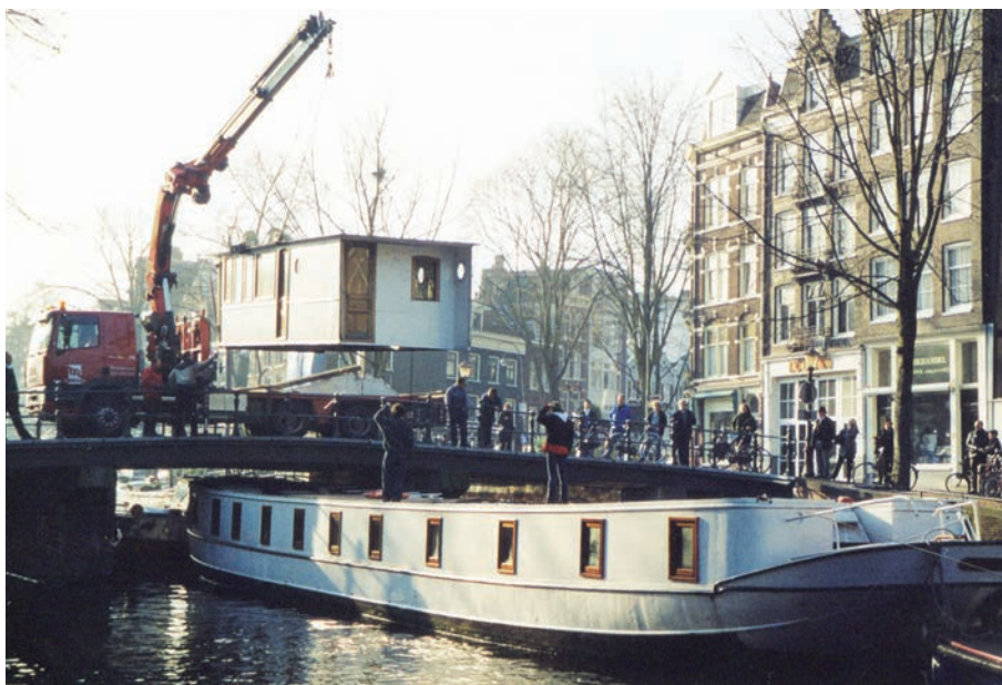
Kijkpunt 4: De stuurhut van de Musard wordt er vanaf getakeld
